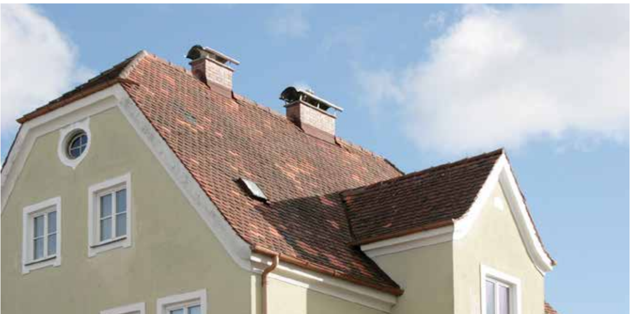
Krüppelwalmdach mit Quergiebel und patinierten Ziegelschindeln (60° Neigung), Salzburger Straße 32
