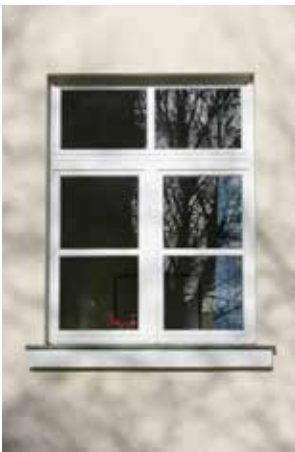
Sprossenfenster (1:1,3), Gelbes Schulhaus
