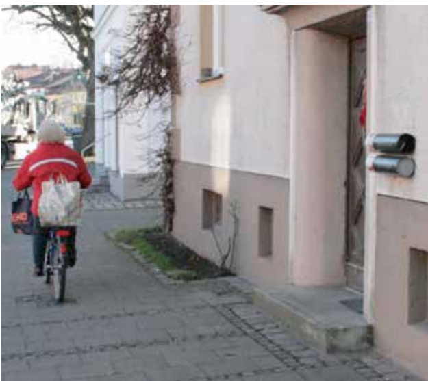
Farbwechsel zwischen Sockel und Fassade, Salzburger Straße 10
