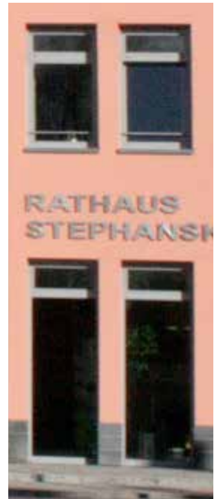
Fenster im OG (1:1,3 ohne Oberlicht) und große Fenster im Sockelbereich, Neues Rathaus
