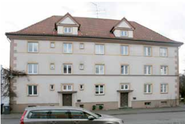
Walmdach mit Aufschieblingen und Giebelgauben, Salzburger Straße 10
