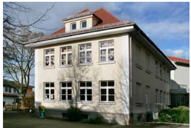
Walmdach mit Aufschieblingen und Walmgaube, Gelbes Schulhaus
