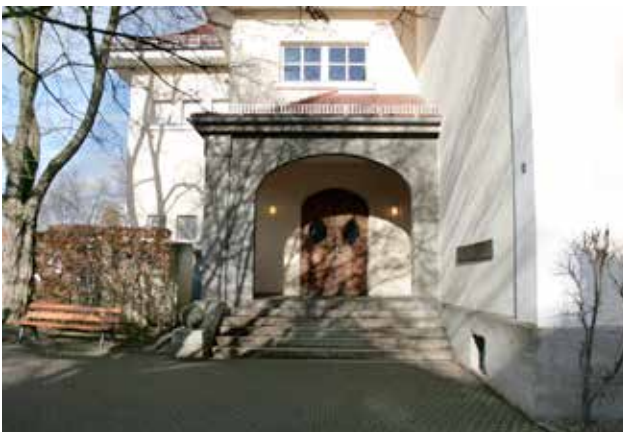
Treppenaufgang zum Eingang des Schulhauses
