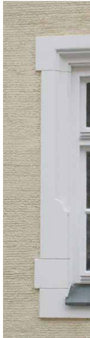
Rechenputz und abgesetzte, glatte Laibung, Rosenheim
