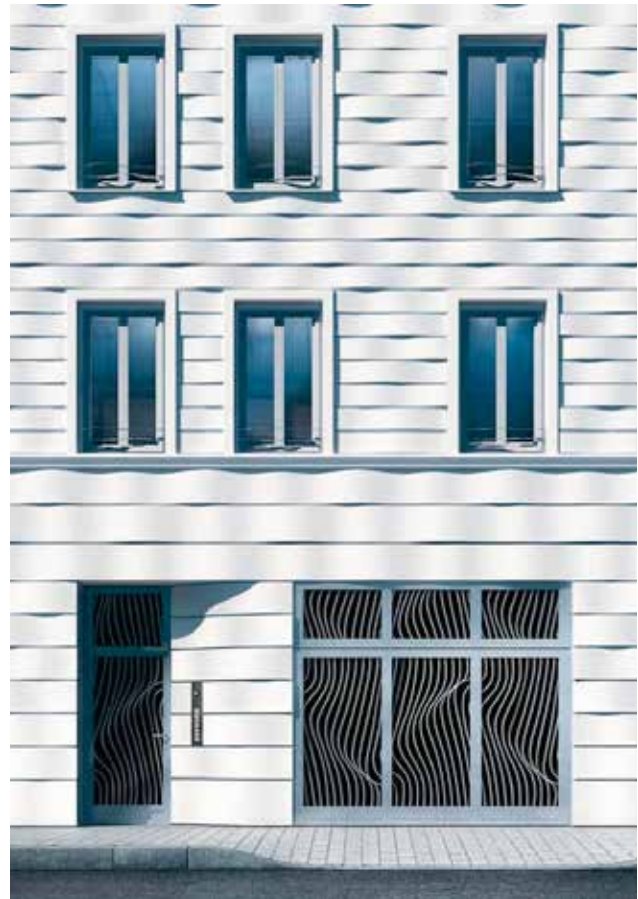
Klar gegliederte Fassade mit einem differenzierten Putzrelief, Reichenbachstraße, München
