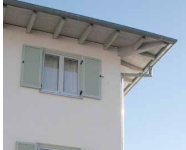
Entwässerungsrohre passen farblich zur Fassade und zur Dachkonstruktion, Kunstmühlstraße, Rosenheim
