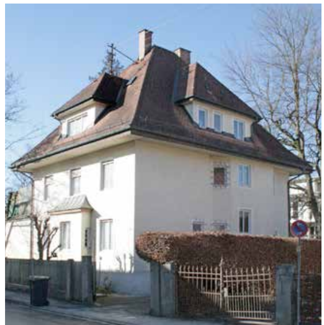
Zeltdach mit Aufschieblingen und Walmgauben, Wasserburger Straße 5
