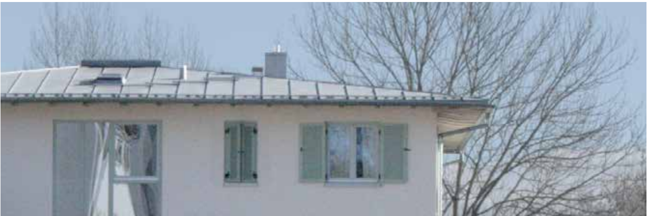
Flaches Zeltdach mit Dachdeckung aus Blech, Kunstmühlstraße, Rosenheim
