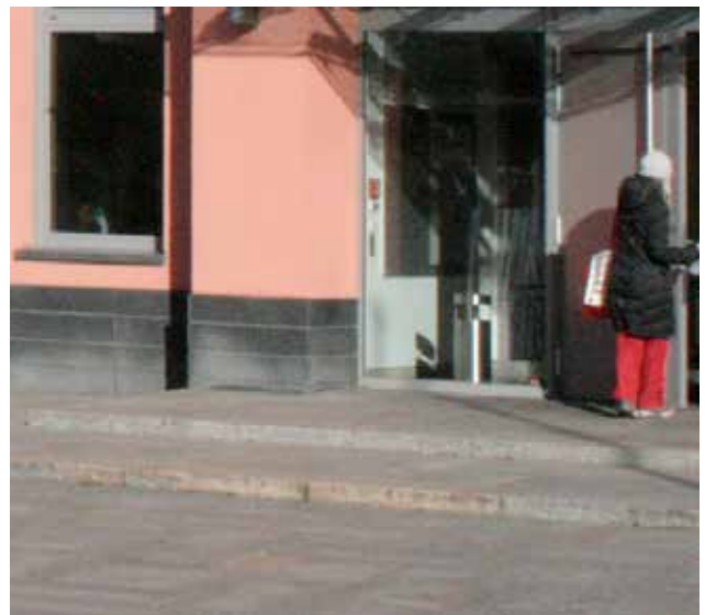
Eingangstrepfenstufen aus Naturstein am Neuen Rathauses
