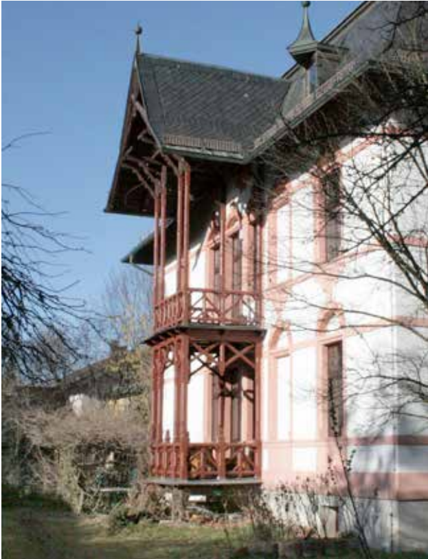
Balkone auf der Rückseite (Hofseite), Salzburger Straße 8
