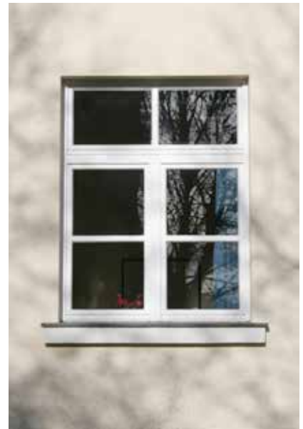
Sprossenfenster im stehenden Format
