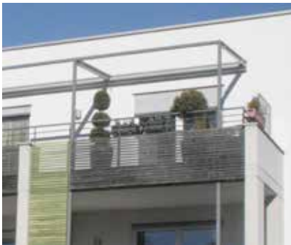
Brüstungen mit Holz verkleidet
