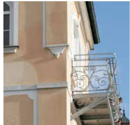
Gesimse, Verzierungen und Putzfaschen erzeugen ein differenziertes Fassadenbild
