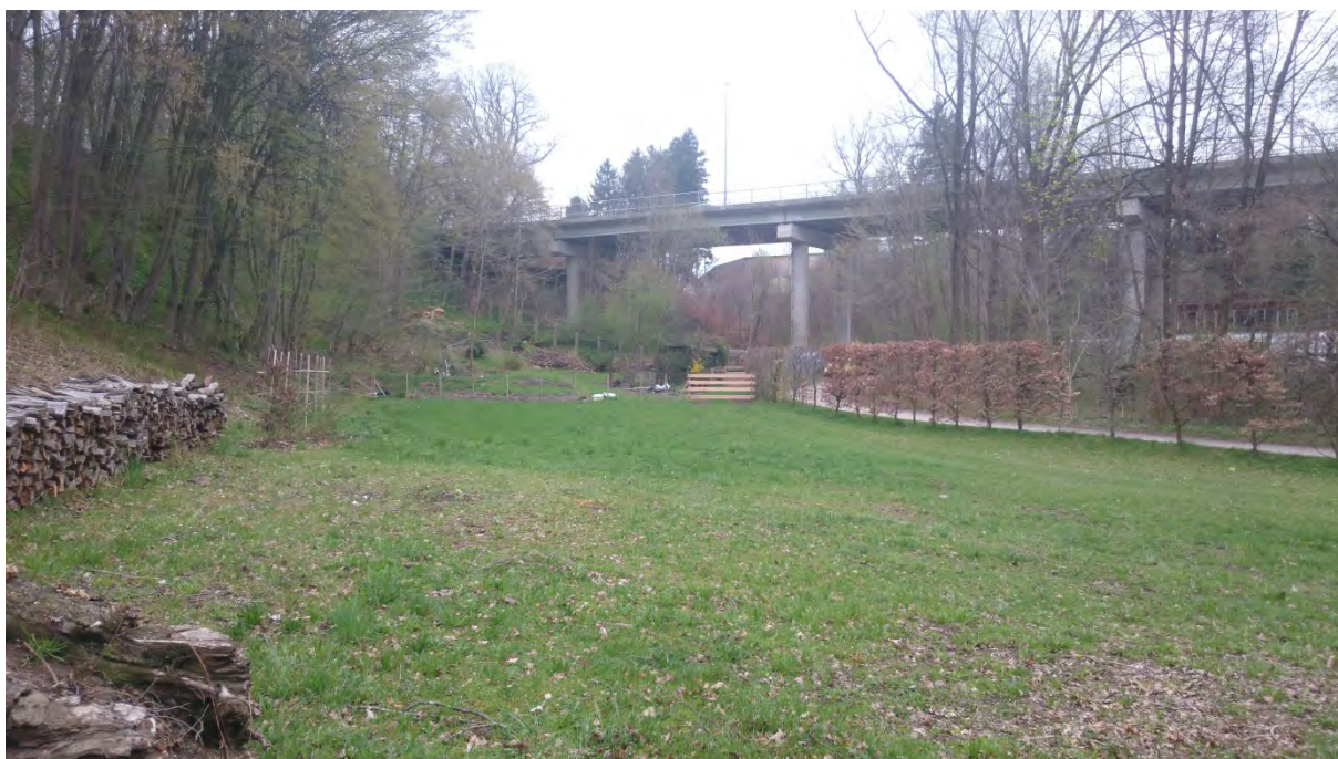
Abbildung 8: Blick nach Nordosten auf das Plangebiet. (Foto: Julia Steil, 10.04.2018)
