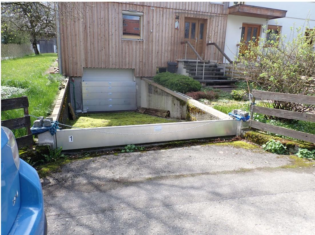
**Abbildung 68: Hochwasserangepasste Bauweise einer Garage in Baierbach**
