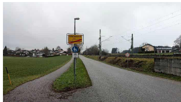
Abbildung 29: Entspricht nicht den Anforderungen an qualitativ hochwertige Radverkehrsanlagen: Die Führung über einen benutzungspflichtigen Geh- und Radweg im Zweirichtungsverkehr innerorts (links), und über einen straßenbegleitenden Gehweg, Rad frei außerorts (rechts)
