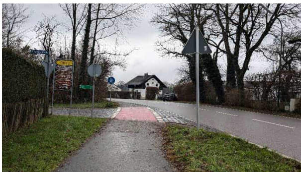
Abbildung 29: Entspricht nicht den Anforderungen an qualitativ hochwertige Radverkehrsanlagen: Die Führung über einen benutzungspflichtigen Geh- und Radweg im Zweirichtungsverkehr innerorts (links), und über einen straßenbegleitenden Gehweg, Rad frei außerorts (rechts)
