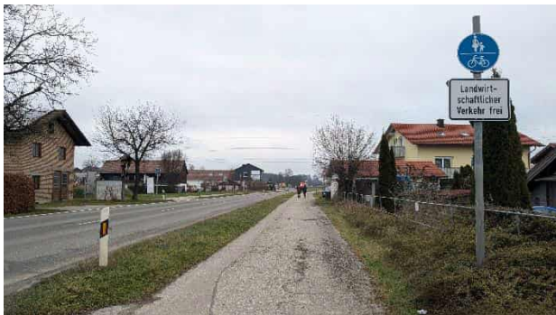
Abbildung 25: Gesicherte Radverkehrsführung: Straßenbegleitender (links) und selbstständig geführter gemeinsamer Geh- und Radweg (rechts)
