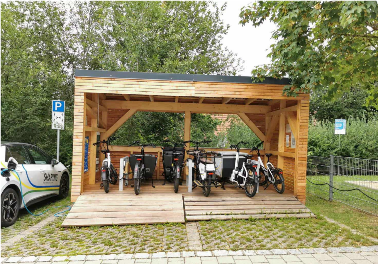
Abb.: Mobilstationen in der Stadt Pfaffenhofen an der Ilm (Foto: Stadt Pfaffenhofen)
