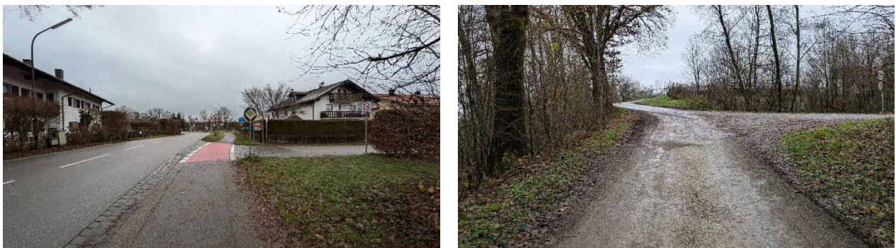
Abbildung 38: Fehlende Kennzeichnung eines Zweirichtungsradweges am BÜ Stephanskirchen (links), fehlende Ortstafel sowie Hinweis auf Führung am Bachfilzenweg (rechts)
