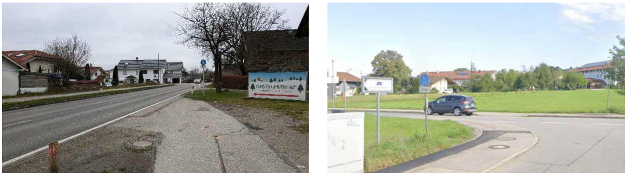
Abbildung 34: fehlende Überleitung zwischen baulichem Geh- und Radweg und der Fahrbahn auf der Äußeren Salzburger Straße (links) und fehlende Überleitung am Ende der Pulvermühlstraße (rechts)
